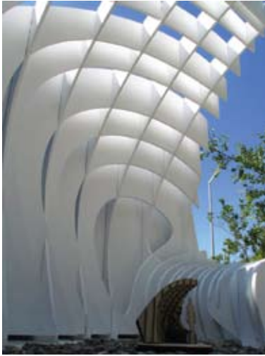
Resim 4. ODTÜ Mimarlık Fakültesi çevresine konumlandırılmak üzere, Arzu Gönenç Sorguç’un yürütücülüğünde ‘Digital Design Studio’da öğrenciler tarafından tasarlanmış olan ‘Space Modulator’ isimli proje Rhinoceros uzantısı Grasshopper parametrik modelleme programıyla tasarlanmıştır. Projede optimize edilmiş ve Fiber Beton malzemesi ile uygulanmıştır. Lazer Kesici ile üretilmiş çeşitli ölçek modellerle tasarımın strüktürel yapısı, malzeme kullanımı, uygulama tekniği test edilmiş, bu doğrultuda parametrik modelde değişiklikler yapılarak optimize edilmiştir.
