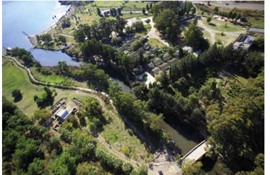
Resim 4. Azmak kıyısında konumlanan ve kıyı dolgusu altında kalan Bizans hamamında kazı, restorasyon ve düzenleme çalışmaları
