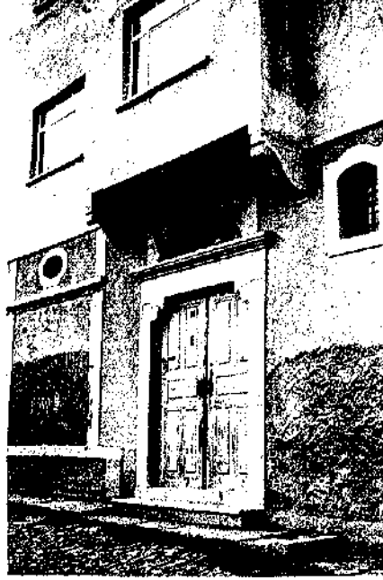
Şekil 16A. Kıranköy'de bir konutun kapı detayı.
