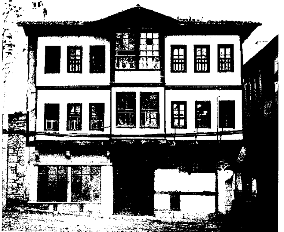
Şekil 8. Karanköy'de Caminin yanında, altında dükkan olan bir konut.
