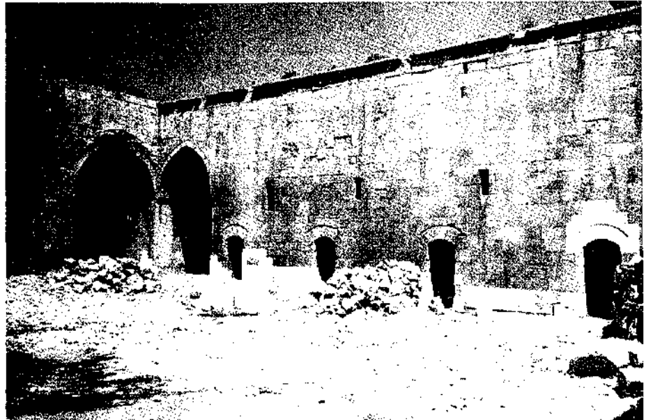
Şekil 17. Mama Hatun Kervansarayı - Avlunun kuzey cephesi
