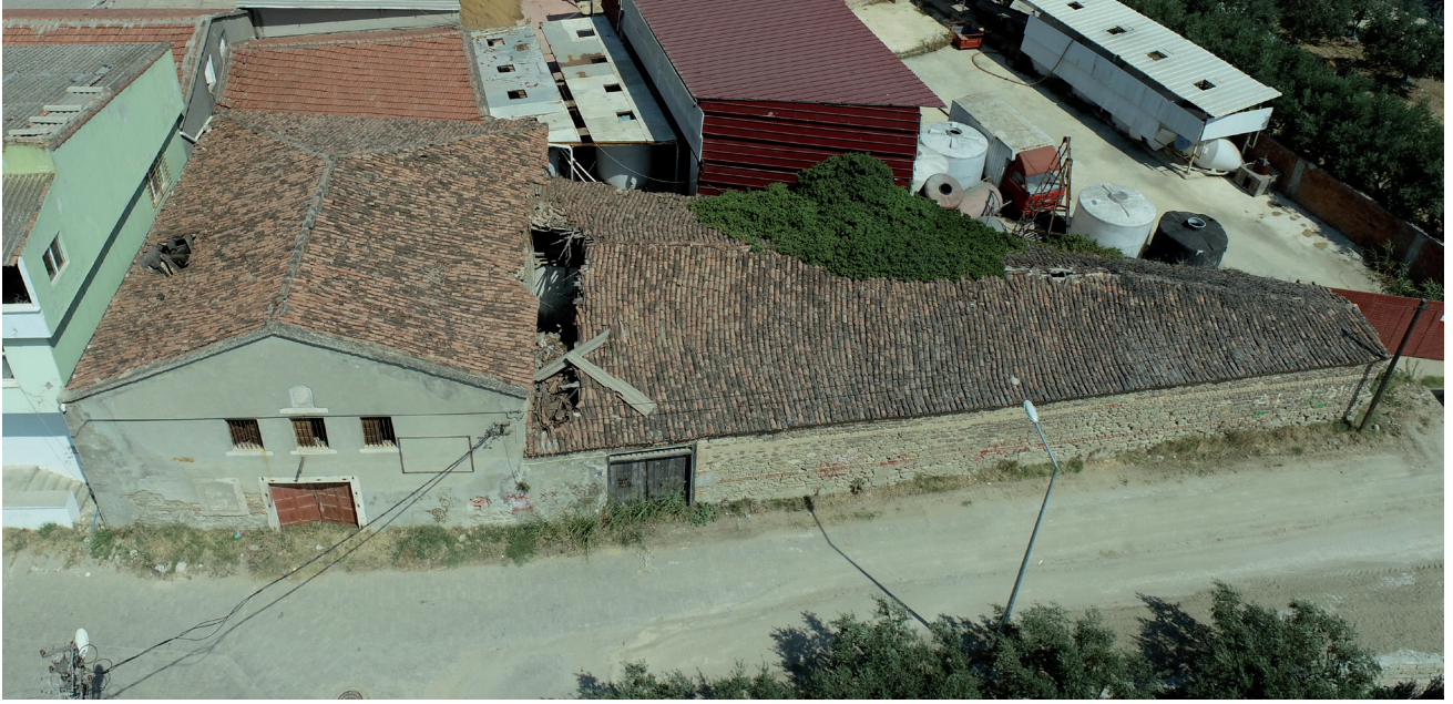
Resim 18. Çatı örtüsü özgün durumda olan bir şaraphanenin kuşbakışı görünüşü (MapSurvey Harita Müh. Tic. Ltd. Şti, 2021).
