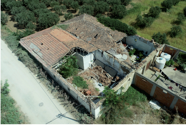
Resim 22. Çatısı kısmen yıkılan şaraphaneler ve çatısında yer yer çökmeler olan şaraphane (MapSurvey Harita Müh. Tic. Ltd. Şti, 2021).
