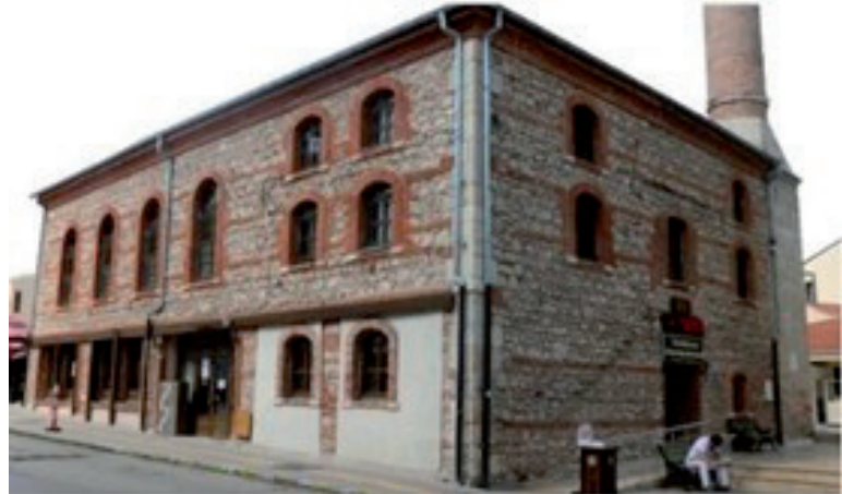
Resim 2. Çalışmanın örneklem binasına ait görsel (Kültür Envanteri, 2025).
