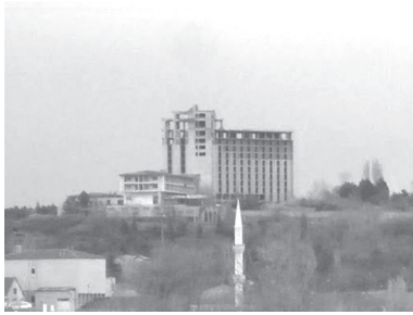
Resim 37. Marmara Oteli Ek Yapı İnşaatı (ODTÜ AOÇ Araştırmaları, 2017).
