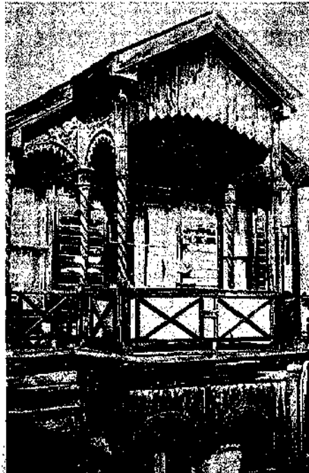
Şekil 20. Eğlence Sokak No.16. Kaldırılan özgün ayrıntılar yerine (spiral kolon, balkon korkuluğu ve zarfı) şzensiz düz bileşenler getiriliyor.
