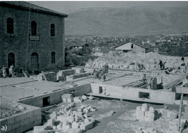
Resim 11. a) Maraş Halkevi inşaatında taş temeller ve zemin kat duvarları. Arka plandaki taş yığınının kiliseden sökülen taşlar olduğu düşünülmektedir (490-1-0-0, 1763-1156-1, 12). b) İnşaatın ilerleyen döneminde aynı yönden duvarlar (490-1-0-0, 1763-1156-1, 54).
