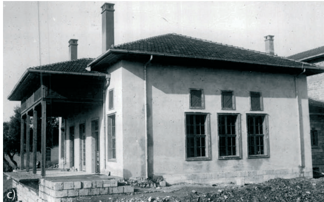
Resim 13. Aile Salonu binası a) Güney cephesi (490-1-0-0, 1763-1156-1, 44). b) Doğu cephesi (490-1-0-0, 1763-1156-1, 48). c) Batı cephesi (490-1-0-0, 1763-1156-1, 36).
