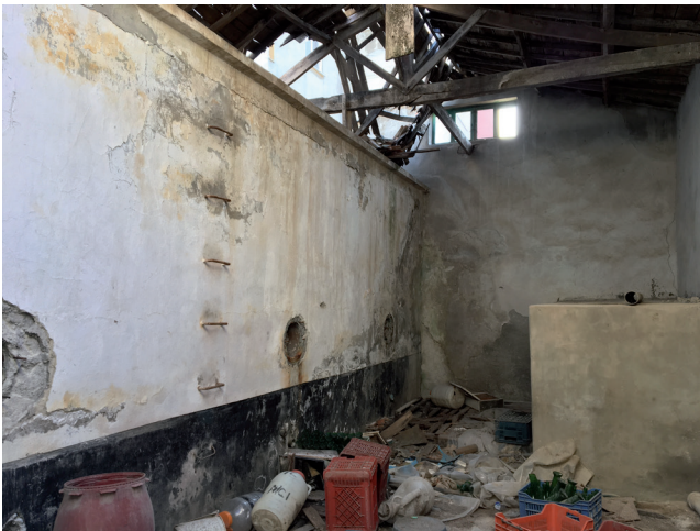
Resim 24. Muhdes bölme eklenen ve tavanı plastik esaslı malzeme ile kaplanan bir şaraphane (Beste Güzel, 2019).
