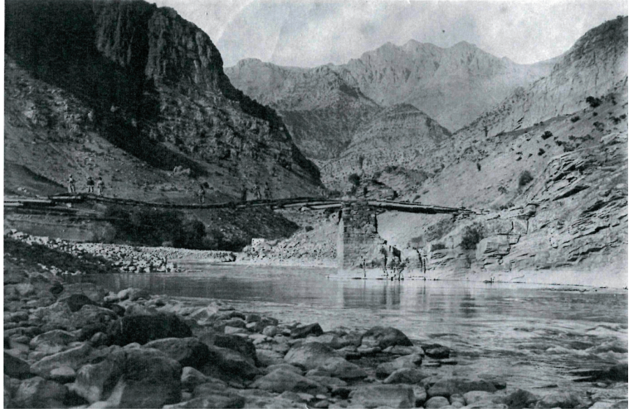
Resim 10. Zap Suyu üzerinden Lizan'a (Taşbaşı köyü bölgesi) giden köprü (Olferiev, 1912).
