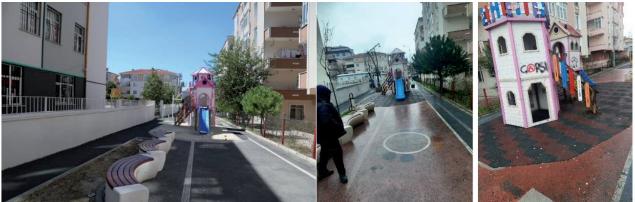
Resim 2. Kapaklı'daki bir oyun alanı: zeminde önce kum alanı uygulaması yapılması ve sonrasında kum alanının yerini kauçuk malzemenin alması (Kapaklı Belediyesi, 2023).
